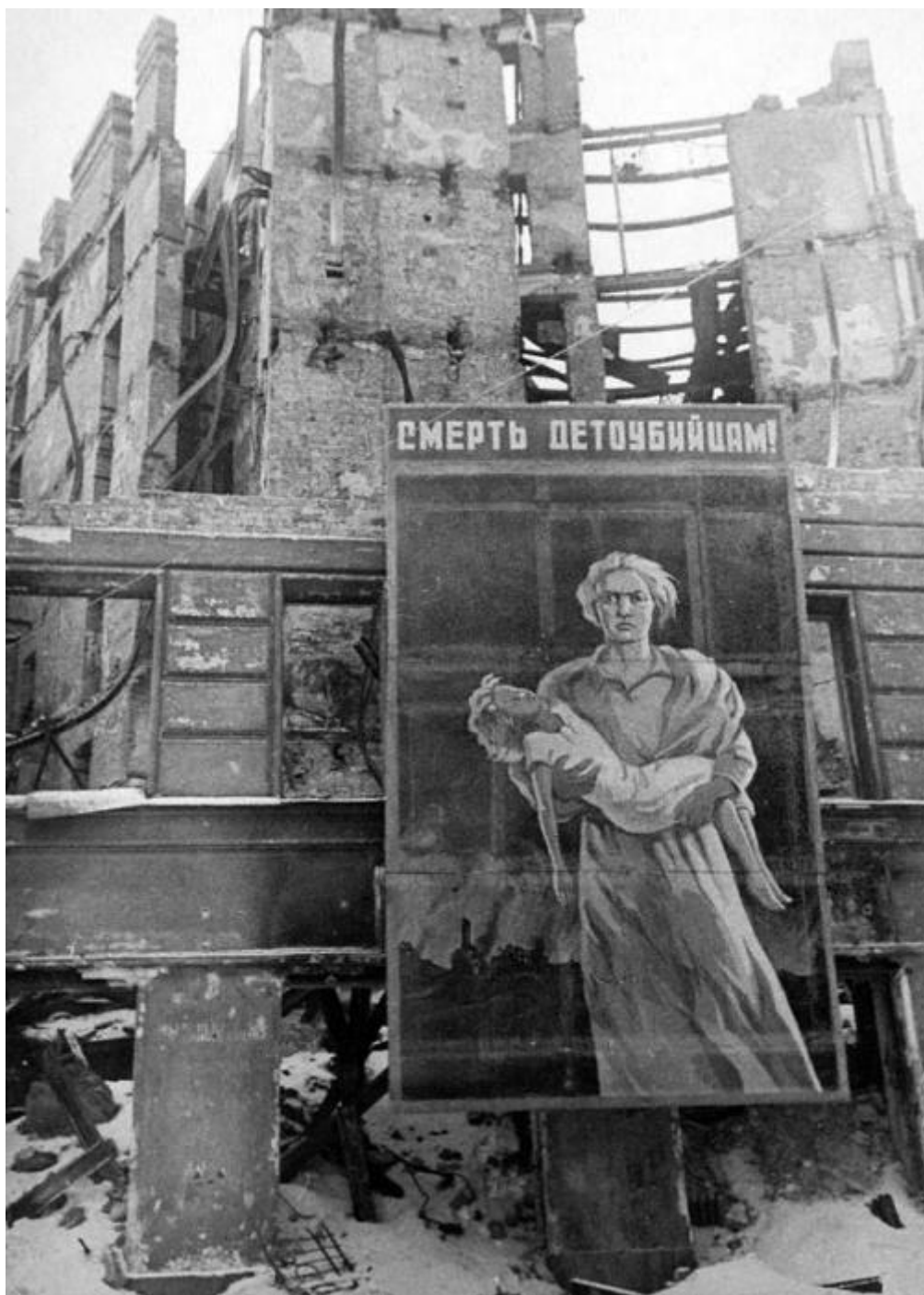
На фасаде разрушенного дома. Угол Лиговского проспекта и Разъезжей улицы
